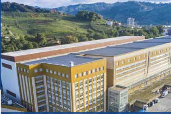
RİZE ÇAY PAKETLEME FABRİKASI İNŞAATI
